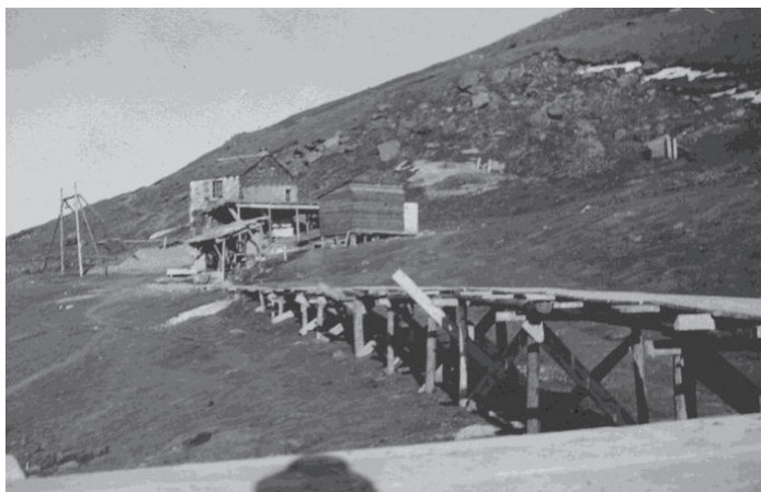
CANTIERE DAVROSIO PER LA COSTRUZIONE DELL'OMONIMO FORTE
