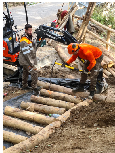
LA PIAZZETTA DEL 90ESIMO IN COSTRUZIONE
